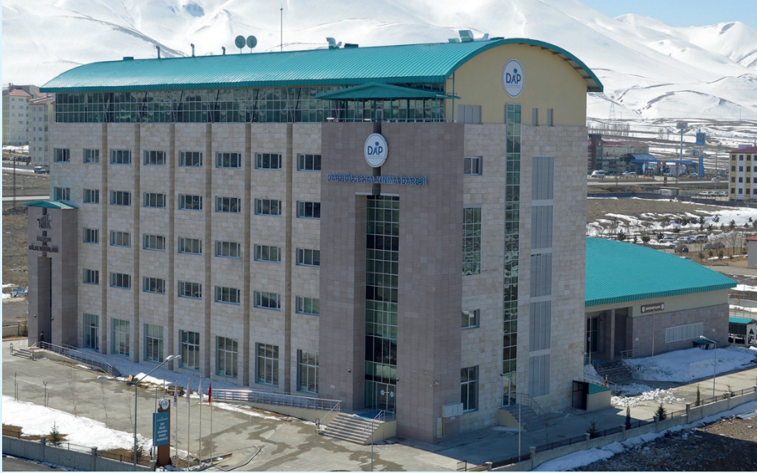
DAP İdaresi Hizmet Binası
